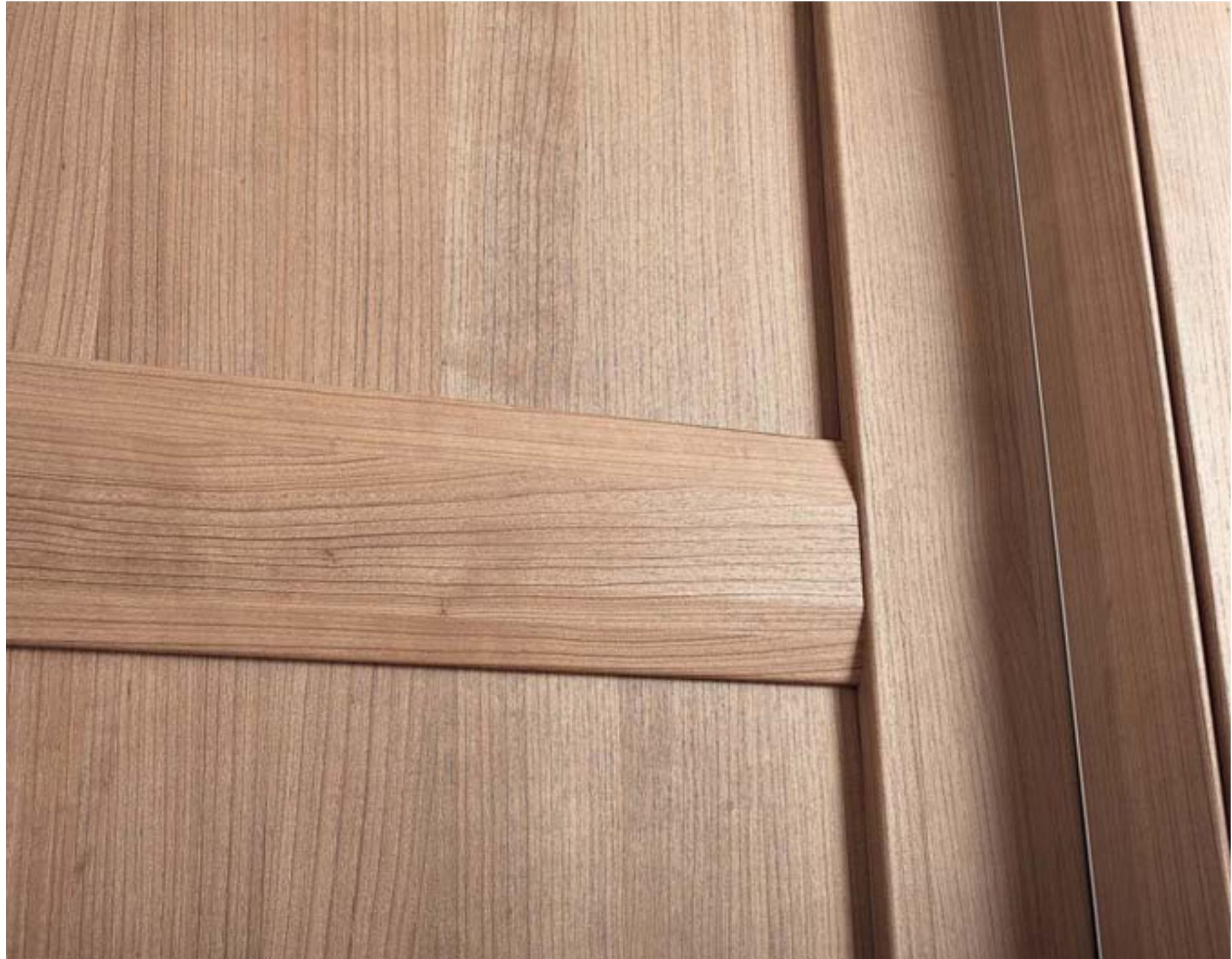
Strutture in legno, con profili rivestiti, spinati, tenonati e assemblati.
