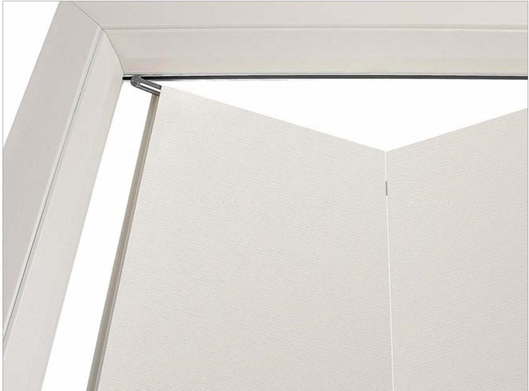
Dettaglio del perno guida della porta Piego 111 Blank.
